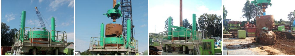
1. 回転治具・反力治具設置 2. EAGLE増速機・掘削バケット設置 3. 回転圧入掘削状況 4. 排土状況
