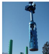
3. 拡底掘削 (EAGLE バケット)
