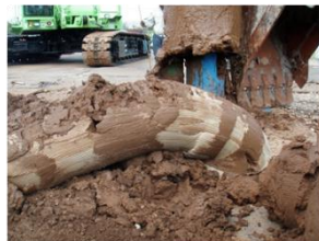
2. 軸部掘削・排土状況
