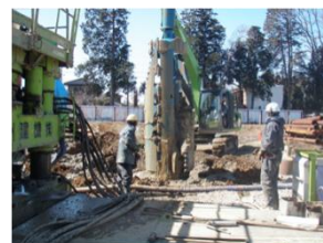
4. 拡底掘削・排土状況
