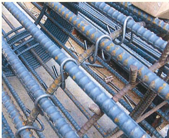
① 主筋と組立補強筋の交点にKSクルリンを間配りする
