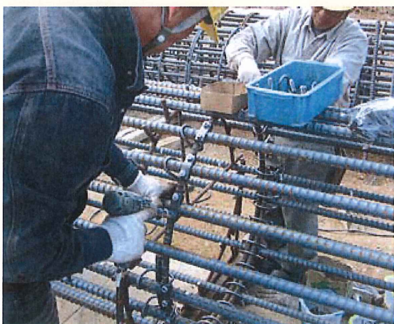
⑤ インパクトレンチで締め付ける
